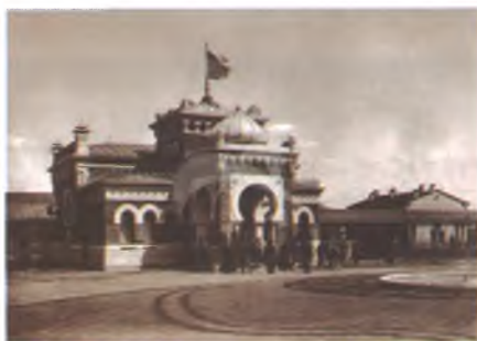
Здание царского павильона Николаевской железной дороги на платформе Каланчевская. 1896 г. Арх. Г.В. Войневич. Фото с сайта: www.mosculture.ru
